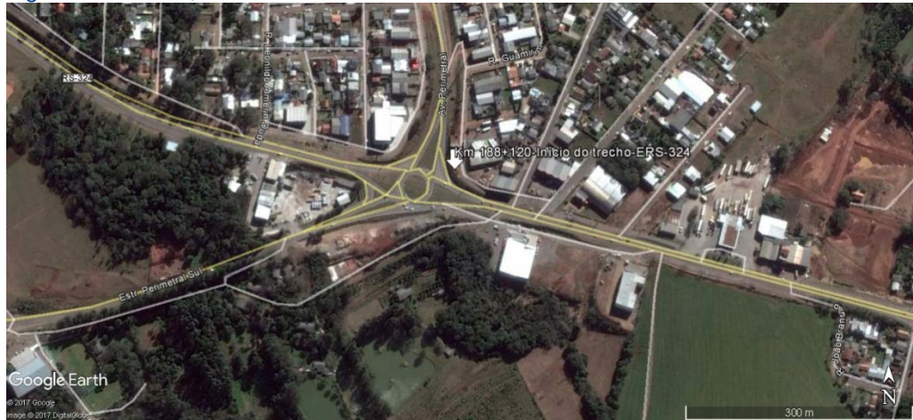
Figura 1 - km 188,12 - Início do Trecho na ERS-324.
