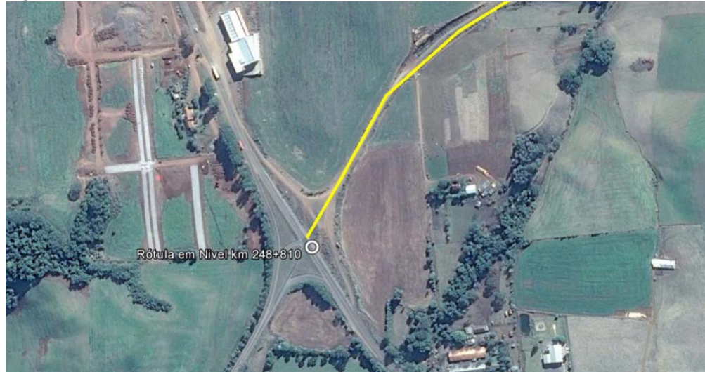
Figura 5 - km 0,00 - Início do Trecho no Entroncamento com a ERS-324.
