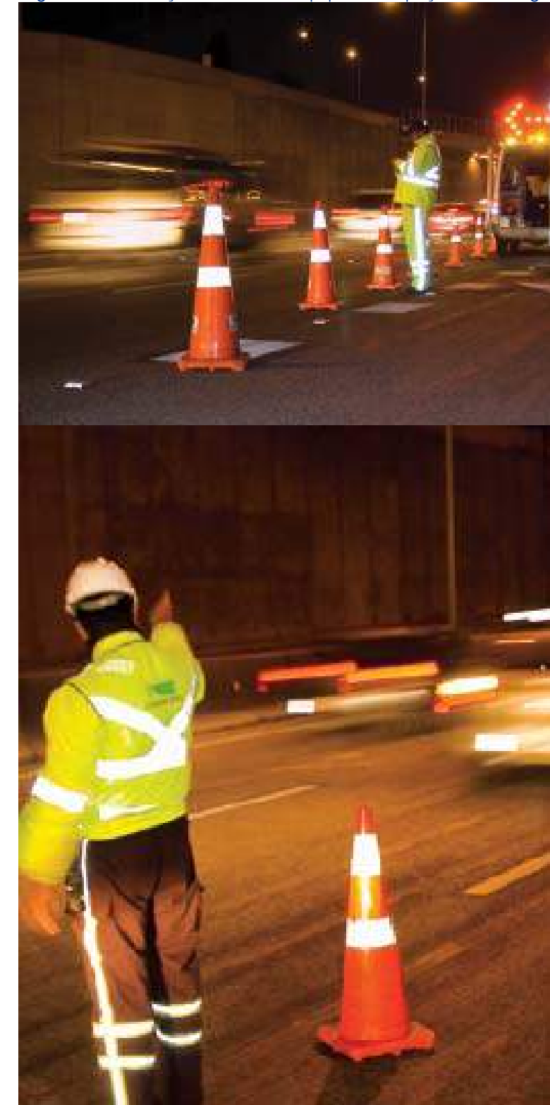
Figura 8 - Sinalização de Vias da Equipe de Inspeção de Tráfego.
