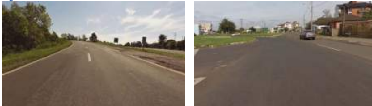
Figura 24 - Início e Fim do Trecho na RSC-287.
