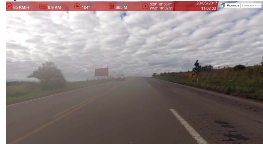
Figura 5 - Plataforma com 3ª Faixa Adicional sem Acostamento.
