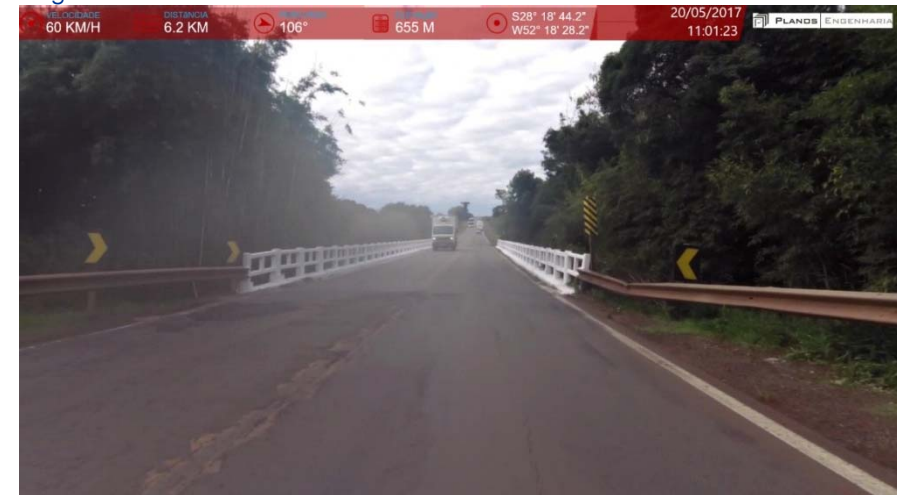
Figura 4 - OAE sem Acostamento.
