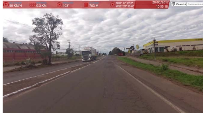
Figura 2 - Pista Simples Dividida por um Pequeno Canteiro Central Pavimentado.
