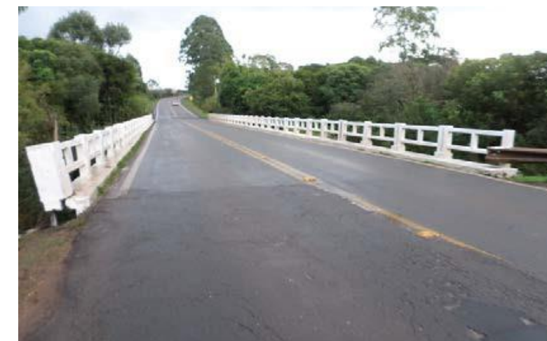
ERS-324 - Ponte sobre o rio Jacuí
